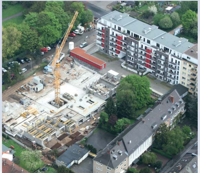
BV Niehler Straße: in 2 Bauabschnitten entstanden 68 Eigentumswohnungen und 11 Einfamilienwohnhäuser
