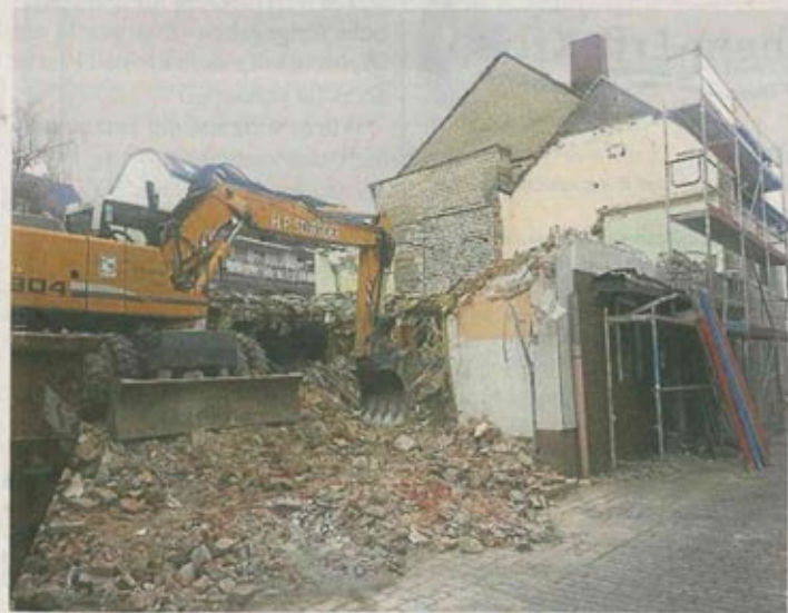
Das Gebäude, in dem früher das Bistro am Stern untergebracht war, wird abgerissen und weicht einem Mehrfamilienhaus.
